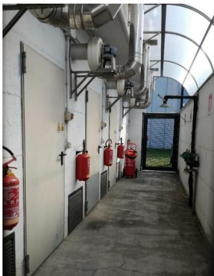
Figura 6 – Esempio posizionamento attrezzature antincendio e aspirazioni
