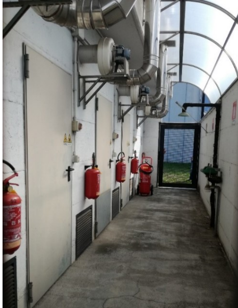
Figura 2 – Esempio posizionamento attrezzature antincendio e aspirazioni
