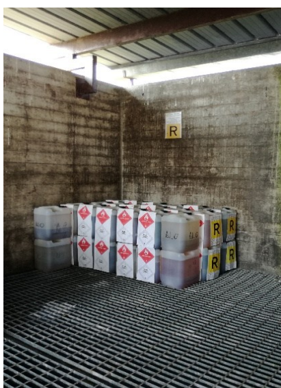
Figura 11 - Esempio di stoccaggio di rifiuti pericolosi in deposito esterno
